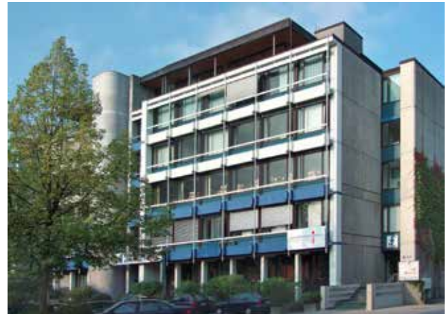
Seit 1953 befindet sich die Landesbüchereistelle Neustadt im Gebäude in der Lindenstraße.
